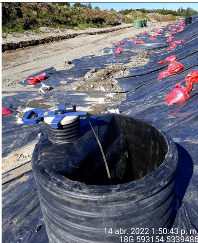
Fotografía N°19: Medición de Niveles de cámaras por Personal Municipal. Tomada: 14 de Abril del 2022.
